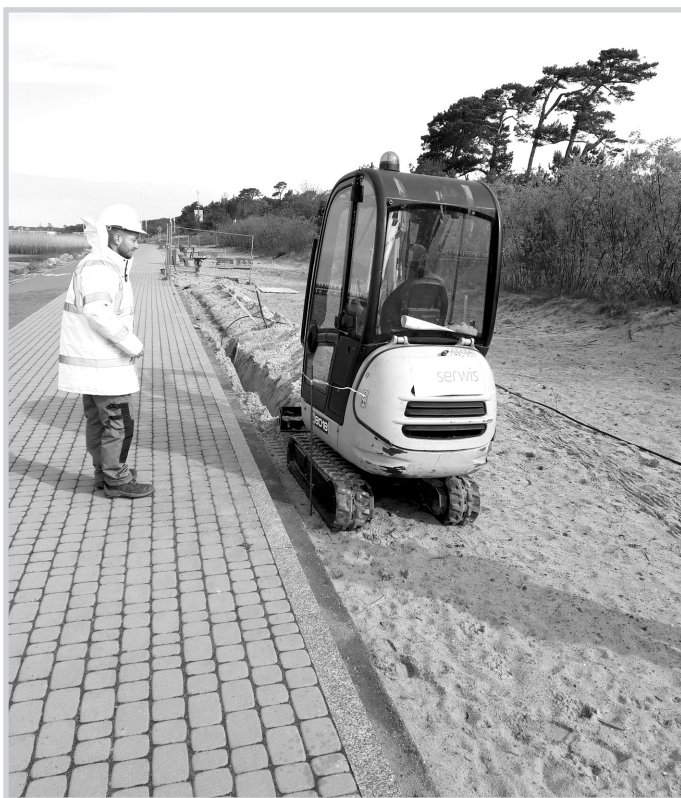
Budowa oświetlenia promenady nadzatomkowej w Juracie
