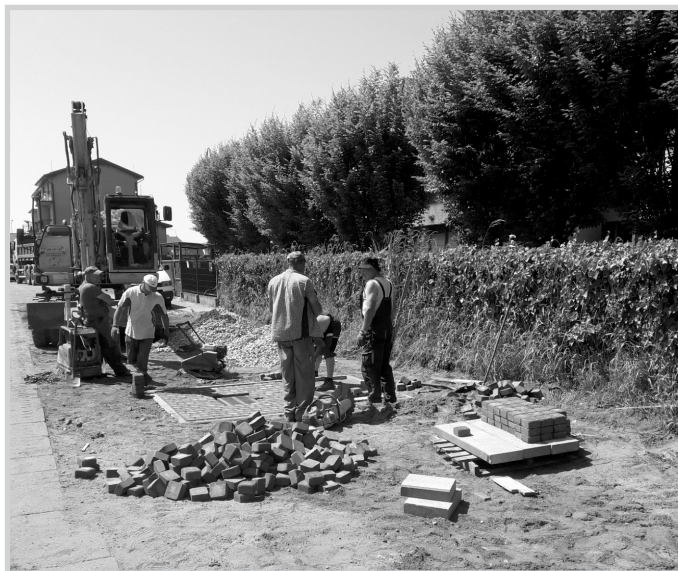
budowa studni chłonnych na ul. Kaszubskiej
