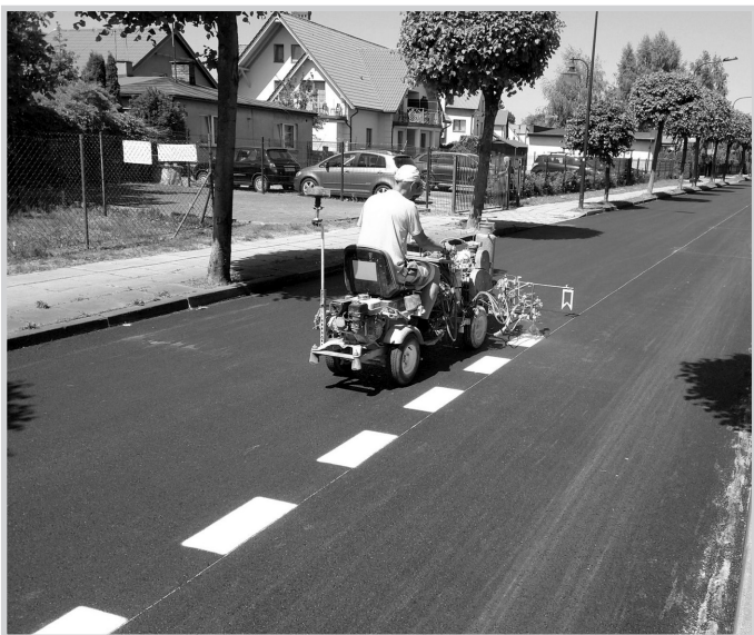
malowanie oznakowania na ul. Ks. B. Sychty
