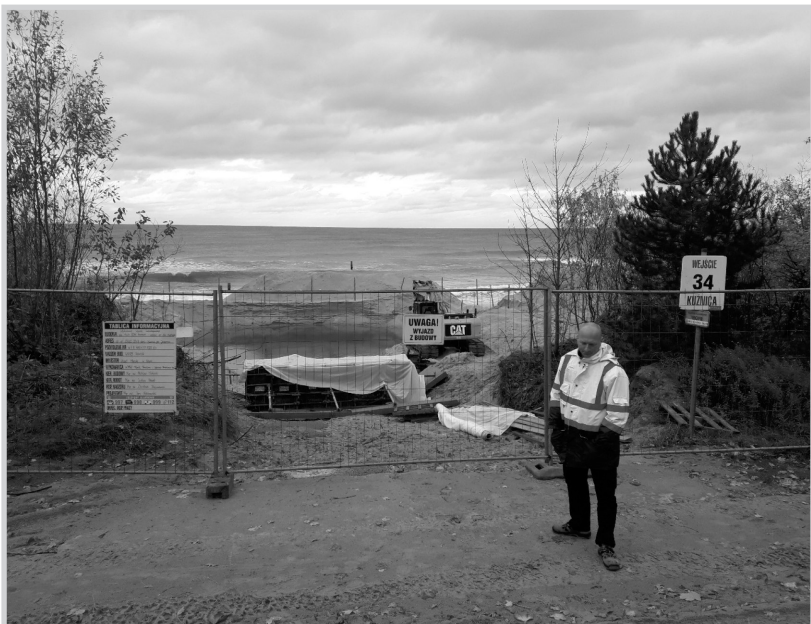
Kuźnica - wejście nr 34 - zjazd techniczny w budowie
