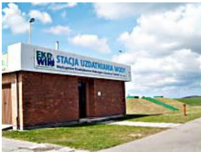
Rysunek 10. Stacja uzdatniania wody Cetniewo. Źródło: http://www.ekowik.com.pl/
