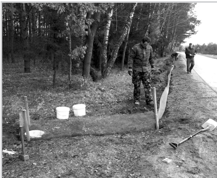
montaż systemu płotków naprowadzających dla płazów
