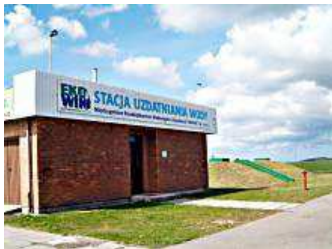
Rysunek 10. Stacja uzdatniania wody Cetniewo.
