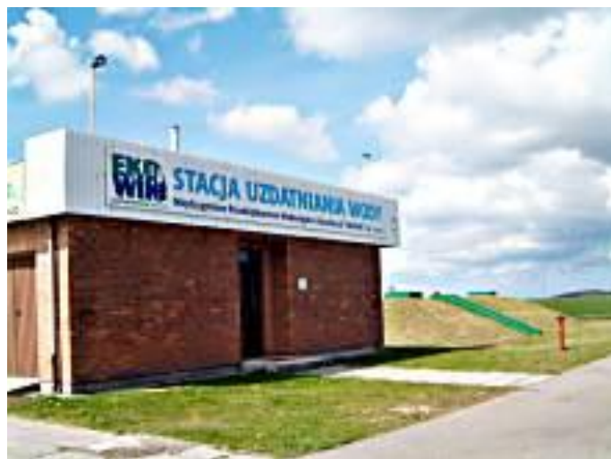
Rysunek 10. Stacja uzdatniania wody Cetniewo.
