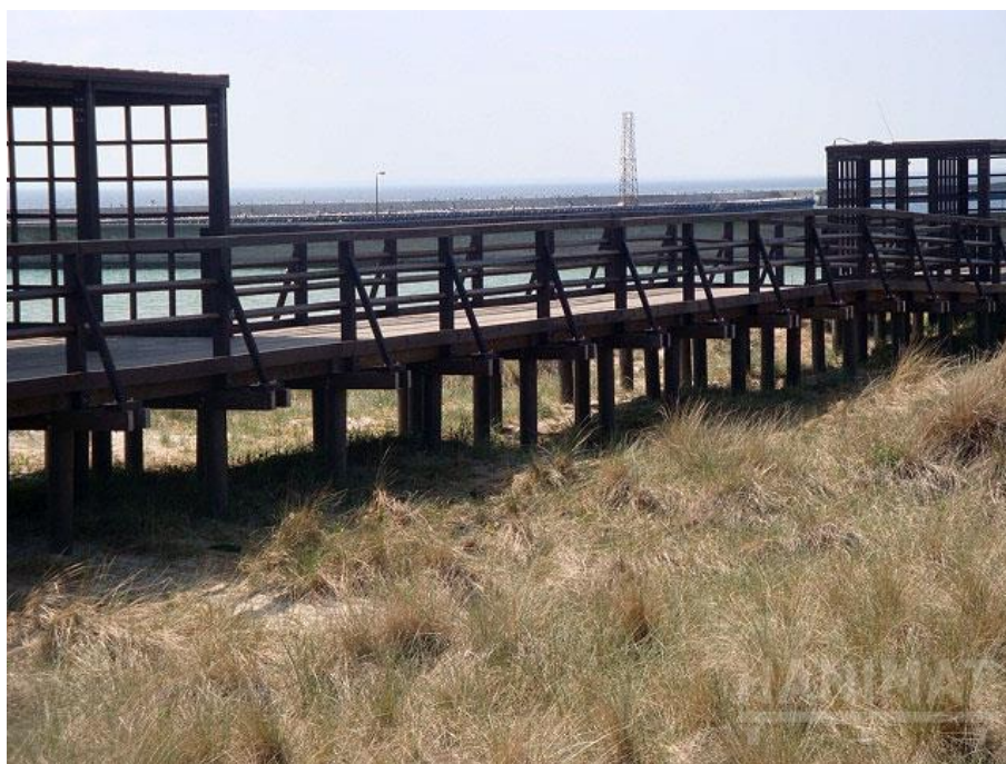
Fot. 3. Rozwiązania konstrukcyjne z zastosowaniem gotowych prefabrykatów typu „Hanimat” na wybrzeżu wydymowym w Helu. Źródło: www.hanimat.pl
