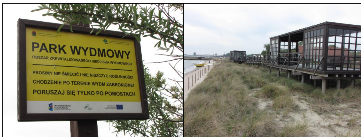
Fot. 8-9. Park wydmy w Helu – tablica informacyjna i przykład kładki dla pieszych na palach (konstrukcja typu „Hanimat”) na zrewitalizowanym siedlisku nadmorskiej wydmy białej z wydmuchrzycą piaskową.
