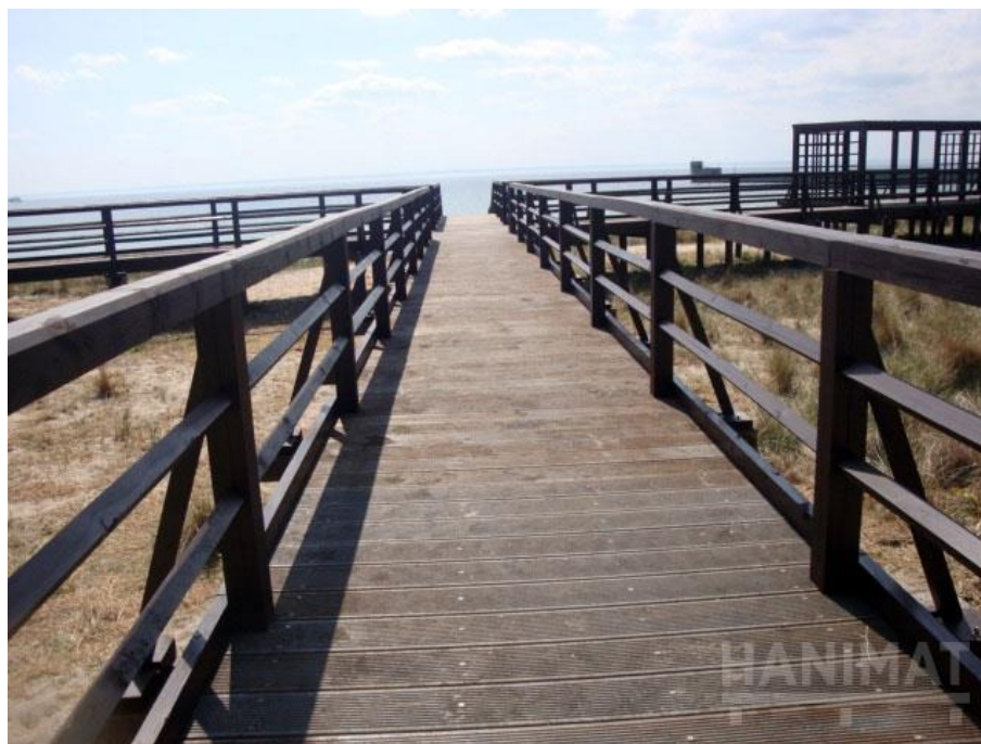
Fot. 1. Rozwiązania konstrukcyjne z zastosowaniem gotowych prefabrykatów typu „Hanimat” na wybrzeżu wydymowym w Helu. Źródło: www.hanimat.pl
