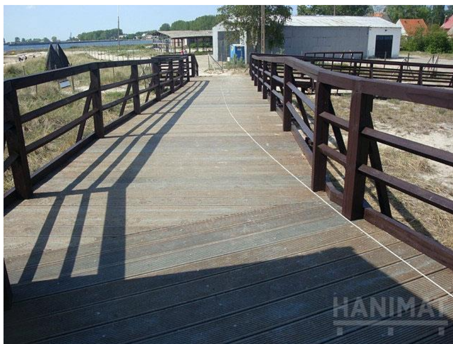
Fot. 2. Rozwiązania konstrukcyjne z zastosowaniem gotowych prefabrykatów typu „Hanimat” na wybrzeżu wydymowym w Helu. Źródło: www.hanimat.pl .
