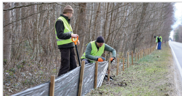
Montaż płotki przy drodze wojewódzkiej 216 przy Uroczysku Każa (Fot. M. Orlikowski)
