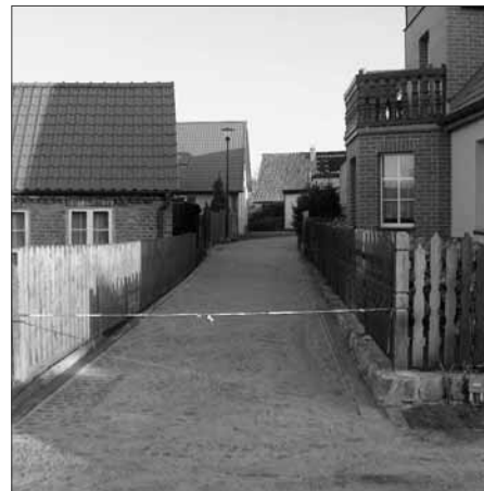
Nowa nawierzchnia ul. Spokojna
