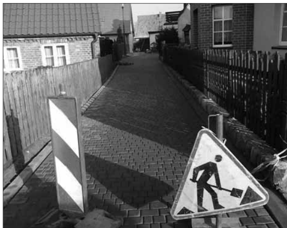
Ulica Spokojna w trakcie prac remontowych.
