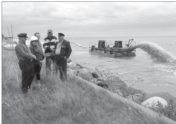
Inspektorzy Urzędu Morskiego w Gdyni i kuźniczenie w czasie prac pogłębiarskich.
