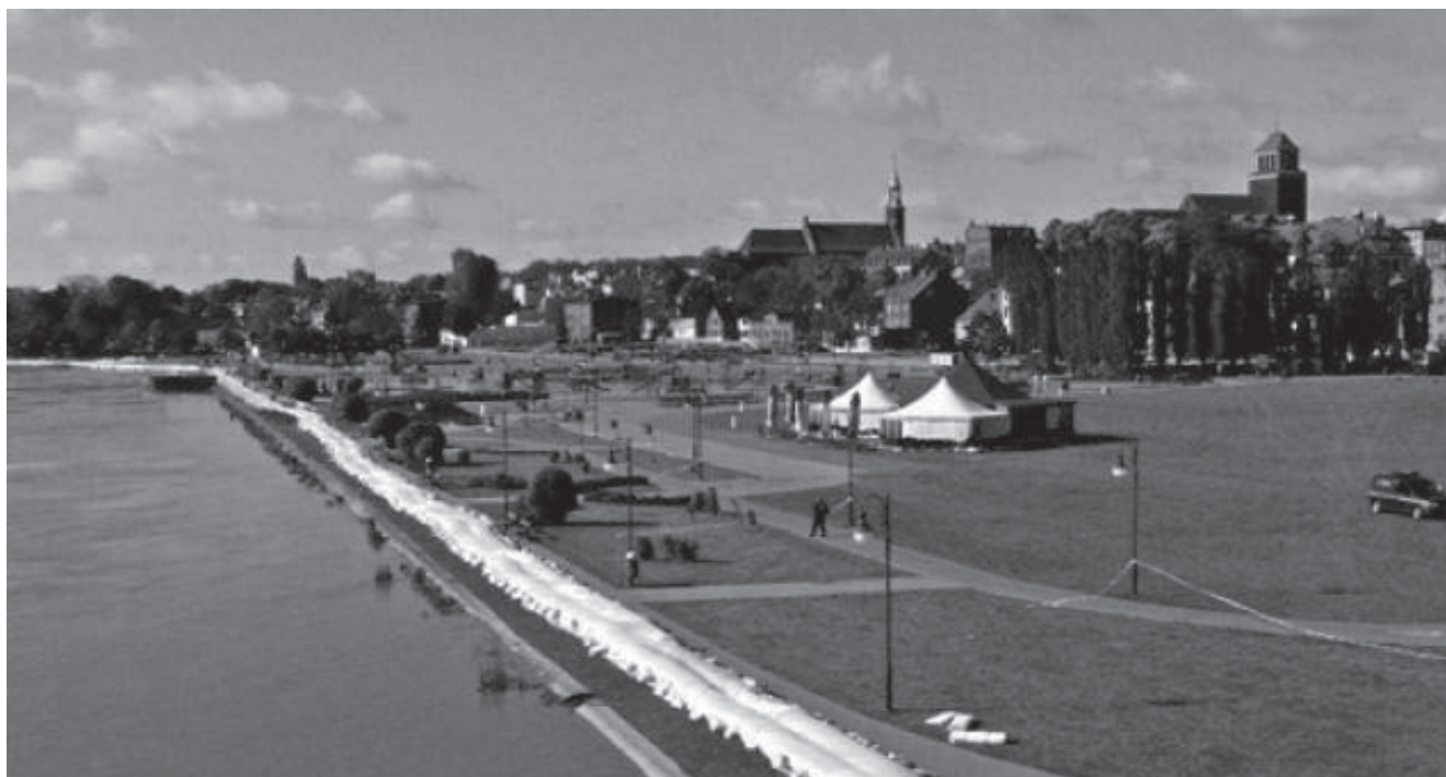
Mobilna zapor przeciwpowodziowa zastosowana w Tczewie w 2010 r. (fot. gazetaczewska.pl)
