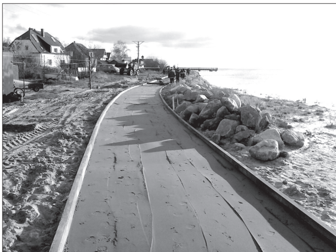
Budowa chodnika spacerowego w Kuźnicy
