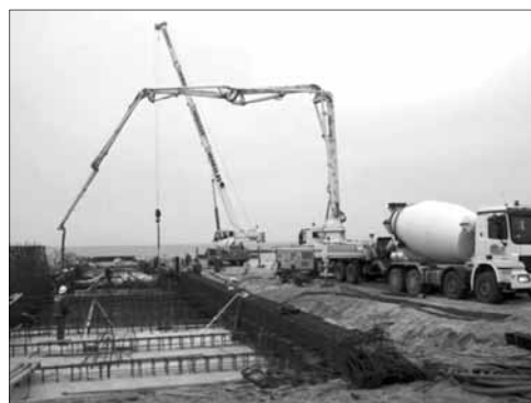
Prace budowlane przy falochronie południowym
