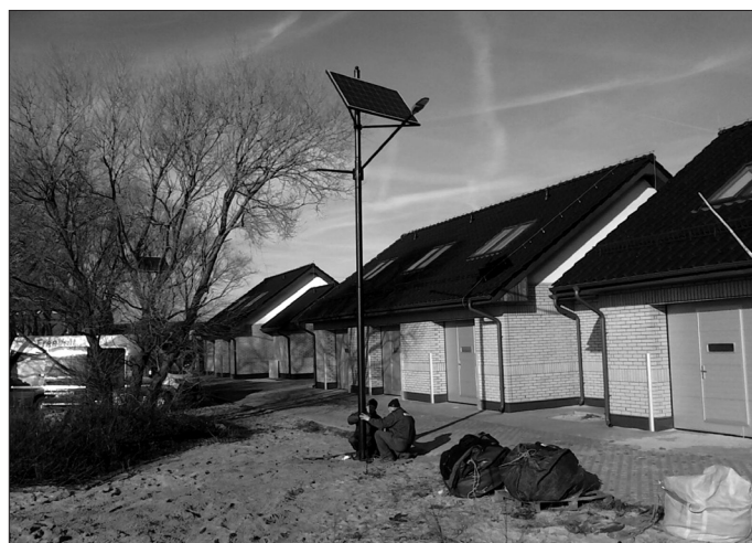
montaż lamp solarnych
