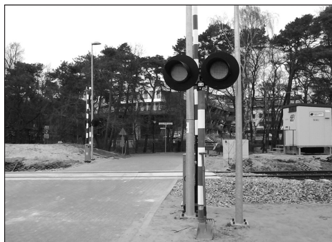
Przejazd kolejowy w ciągu ulicy Kościuszki w Jastarni.
