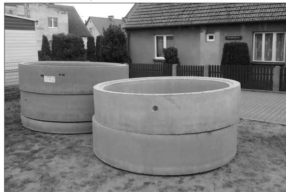
Zmagazynowany w Kuźnicy materiał na studnię chłonną.
