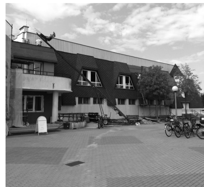
Roboty budowlane na hali sportowej
